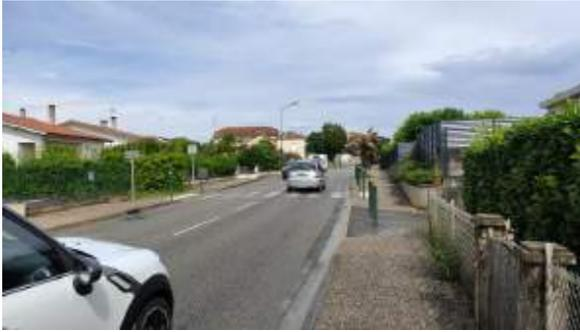
La D119 au niveau du centre-ville de Brax. Une chaussée unique à 6m qui permet de maîtriser la vitesse des véhicules
