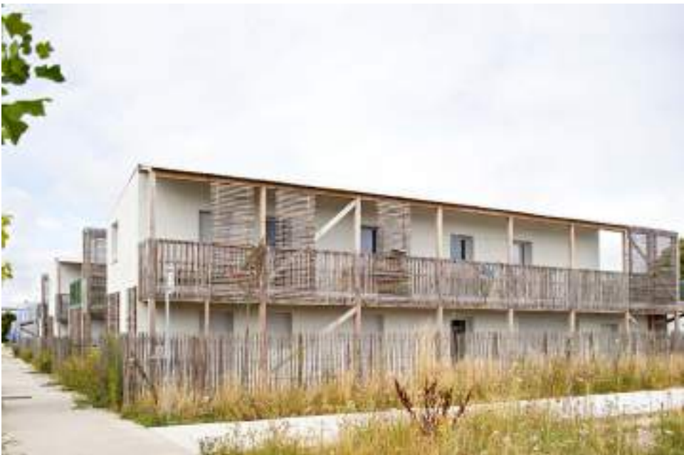
Huit logements collectifs à Trignac (44)
