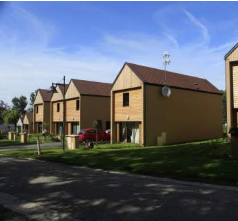
Logements individuels en bois à Urcel (02)
