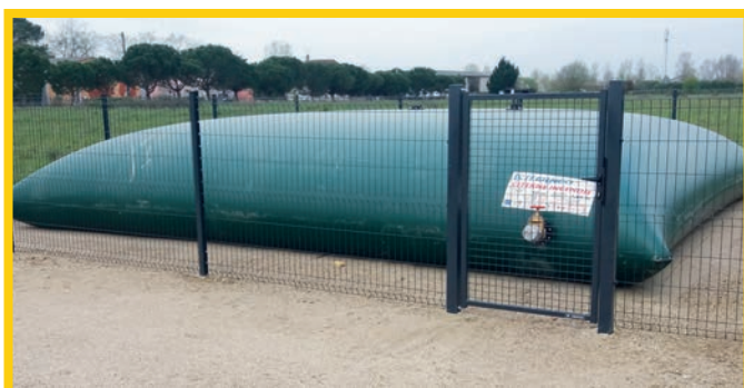
Installation d'une bâche incendie au Chemin de Lestagné
