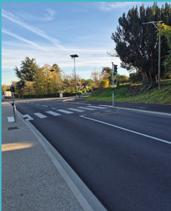
Sécurisation du carrefour de Commarque/ Le Pintre
